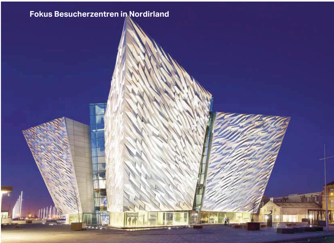
↑ Einem Schiffsbug nachempfunden, ragen die Gebäudespitzen des «Titanic Belfast» in die Höhe. Im Licht schimmert die Fassade wie ein Eisberg.
