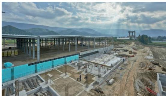
Die Fundamente für den Bürotrakt sind gelegt. Die Vorarbeiten für eine zukünftige Erweiterung sind ebenfalls eingeplant.
