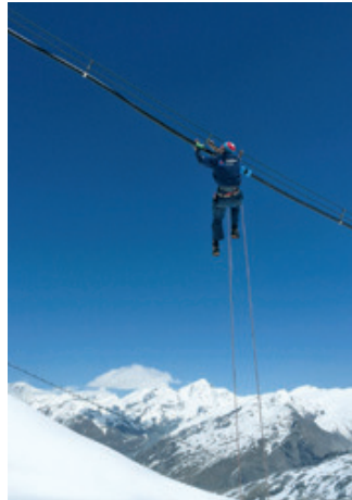
Kurz vor der Inbetriebnahme: Projektleiter Pascal Zenhäusern von der Firma Lauber IWISA (Mitte) bespricht mit den Installateuren die letzten Arbeitsschritte. Das gesammelte Schmelzwasser wird neu über eine 250 Meter lange Schwebeleitung zur Hütte hochgepumpt.
