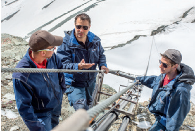
Kurz vor der Inbetriebnahme: Projektleiter Pascal Zenhäusern von der Firma Lauber IWISA (Mitte) bespricht mit den Installateuren die letzten Arbeitsschritte. Das gesammelte Schmelzwasser wird neu über eine 250 Meter lange Schwebeleitung zur Hütte hochgepumpt.
