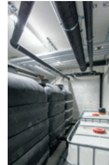
→ Blick in den Technikraum: Die riesigen Grauwassertanks sind ein Beleg dafür, dass hier oben jeder Tropfen Wasser wertvoll ist.
