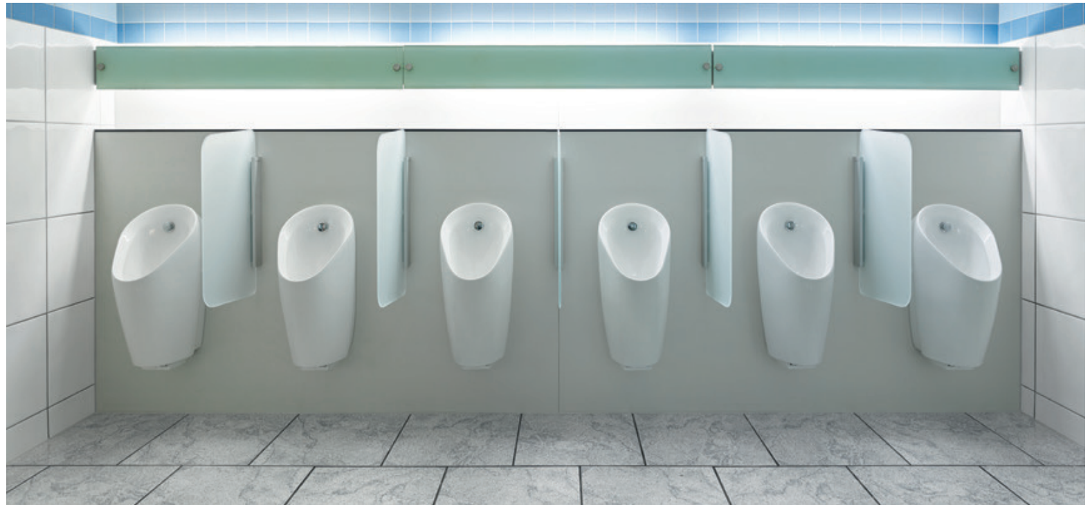
↑ Nachher: Die Teilrenovation dieses Toilettenraums mit sechs neuen Geberit Preda Urinalen und Geberit Urinaltrennwänden nimmt nur vier Tage in Anspruch.
