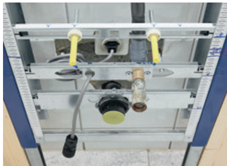
↑ Die Geberit Duofix Montageelemente für Urinalsysteme sind für den Einbau der Modelle Preda und Selva vorbereitet.
