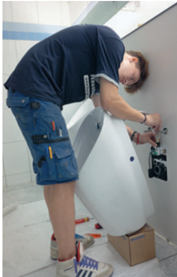
↑ Der Anschluss eines Geberit Urinals an die Wasserver-sorgung ist dank werkseitig vorbereiteten Panzerschläu-chen im Nu erledigt.
