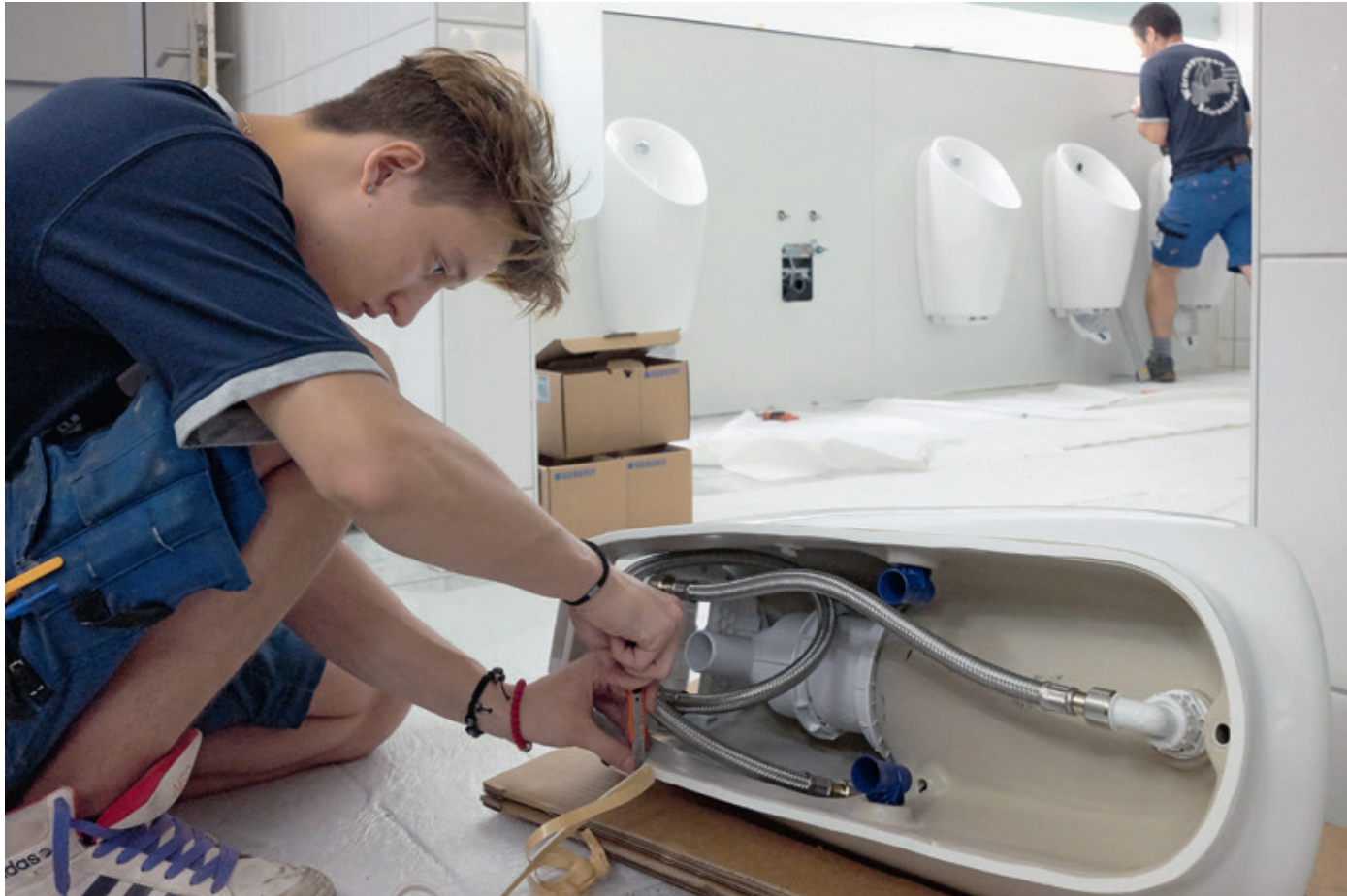
← Yannick Ramseier, Lernender bei Bürge Haustechnik AG, bereitet ein Geberit Preda Urinal für den Einbau vor. Im Hintergrund sieht man seinen Chefmonteure, Paul Arnold, bei der Montage von Urinaltrennwänden.
