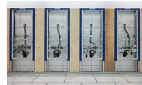
↑ Die Duofix Montageelemente lassen sich ohne grossen Anpassungsaufwand an die bestehenden Anschlüsse für Wasser, Elektrizität und Abwasser anschliessen.
