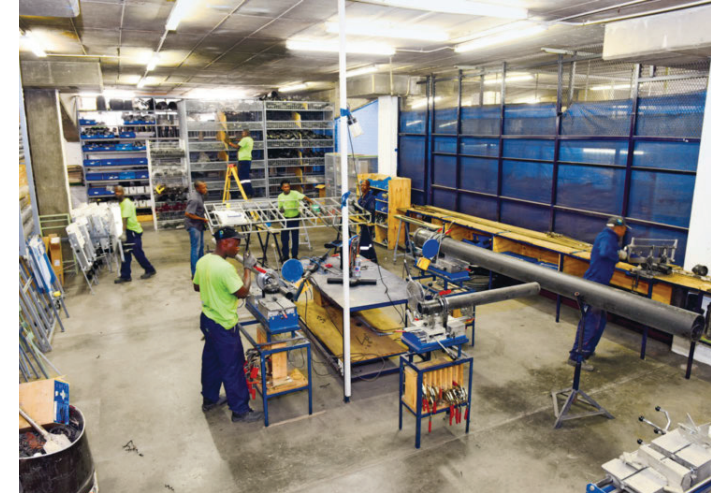
↑ Spiegelschweißen der Geberit PE-HD-Rohre in der nahegelegenen Werkstatt: Die Firma Modern Plumbing Works konnte den ambitionierten Zeitplan dank Vorfertigung einhalten.
