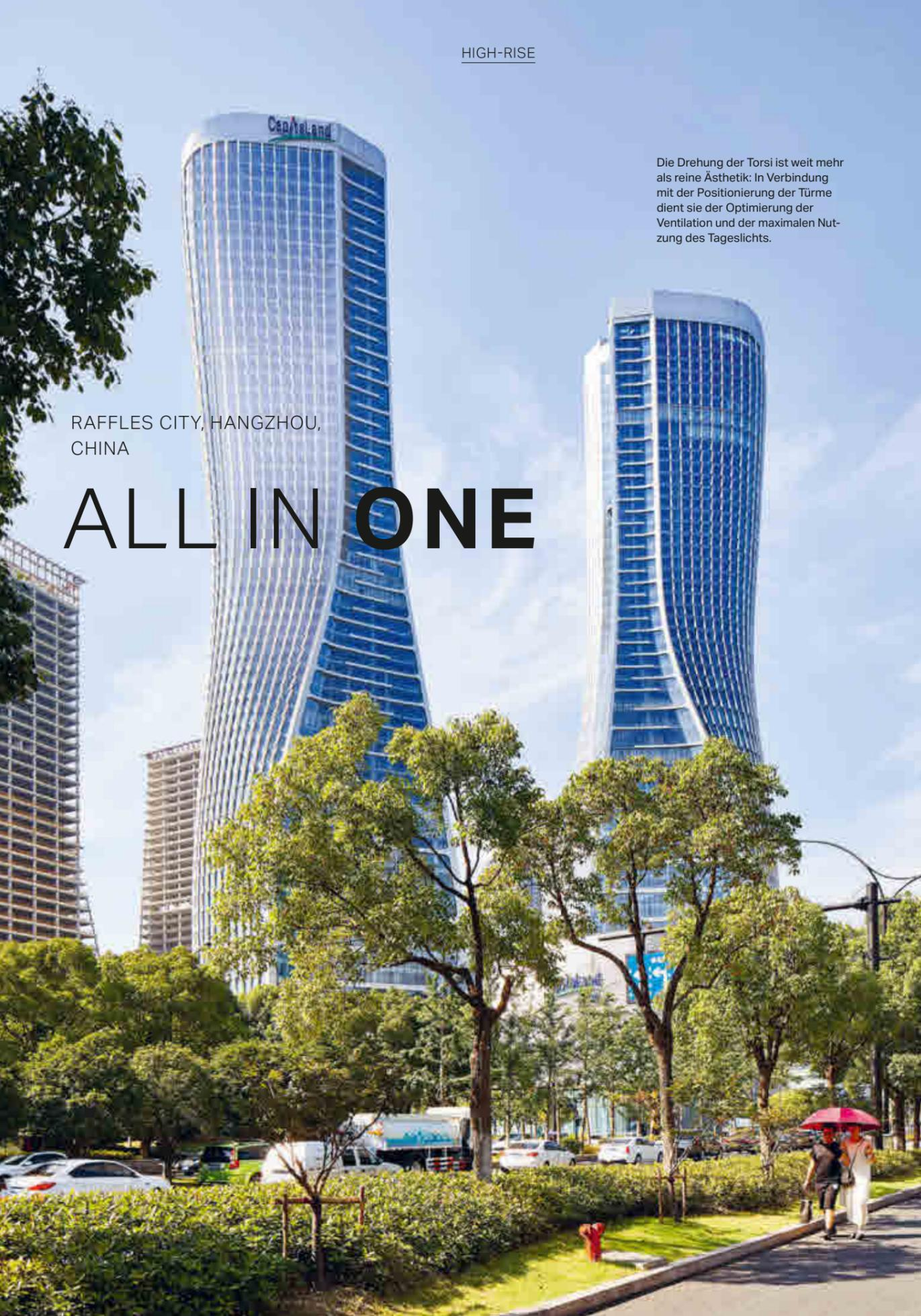
Die Drehung der Torsi ist weit mehr als reine Ästhetik: In Verbindung mit der Positionierung der Türme dient sie der Optimierung der Ventilation und der maximalen Nutzung des Tageslichts.
