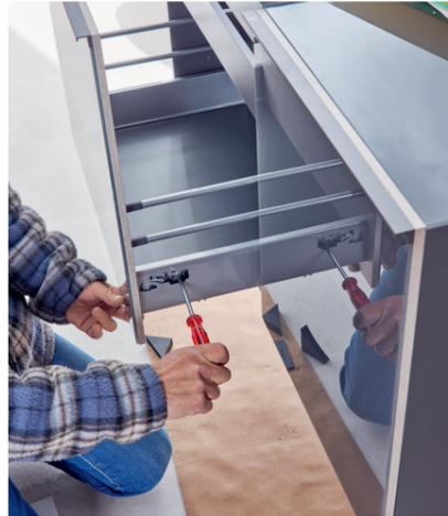
→ Die Justierung der Auszüge und Möbel erfolgt in vier Dimensionen: horizontale und vertikale Neigung, Höheneinstellung sowie eine spezielle Justiermöglichkeit für die Fronten.
