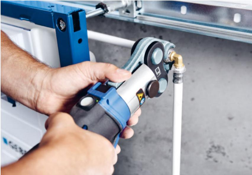
↑ Die Pressverbindungen sind sicher und dicht und ermöglichen ein effizientes Arbeiten auf der Baustelle.
