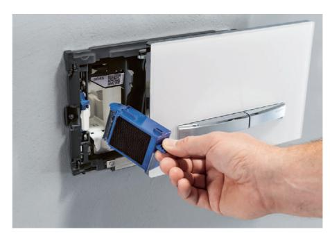
Der Keramikwabenfilter und die Spülkastensticks sind leicht zugänglich.
